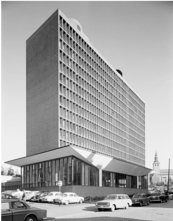
Høyblokka. Foto: Teigens Fotoatelier 1958-59. Oslobilder.no.
