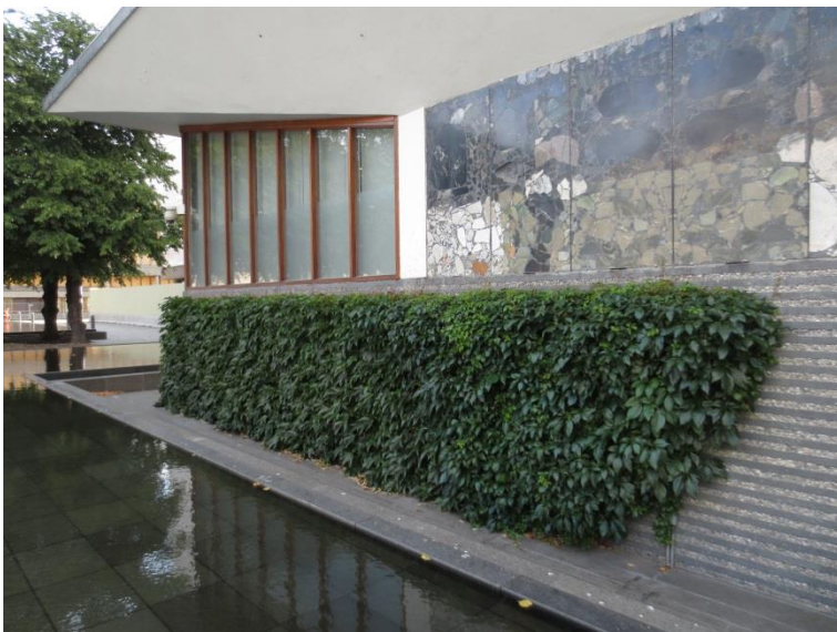
Paviljong med conglobetong. Foto: Siri Hoem 2013.
