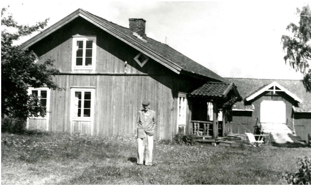
Bilde 1: Foto av Harald Aamodt ved våningshuset rundt 1960. Rælingen historielags fotosamling.
