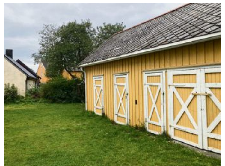
Uthus i Kirkevegen 11 som er planlagt revet.
