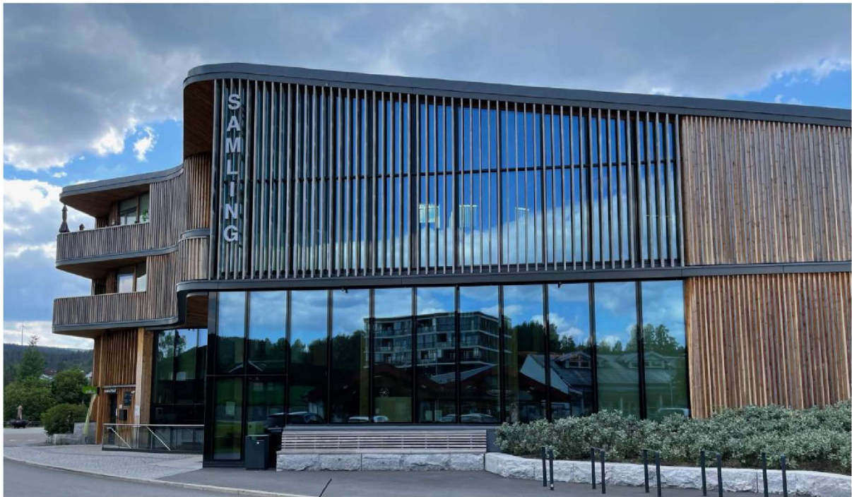
Figur 7. Folkebiblioteket Samling; et kombinert bibliotek, forretnings- og boligbygg på Sand i Nord-Odal. Foto Cato Rønold
