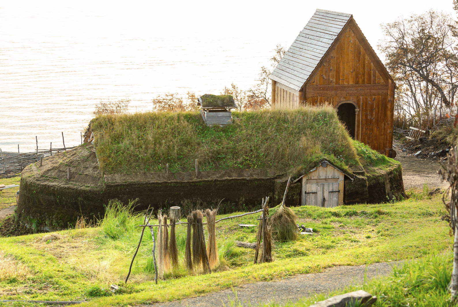
ÅRESTUAS TYKKE TORVVEGGER ble bygd av islandske håndverkere med bistand fra museets eget personale.
