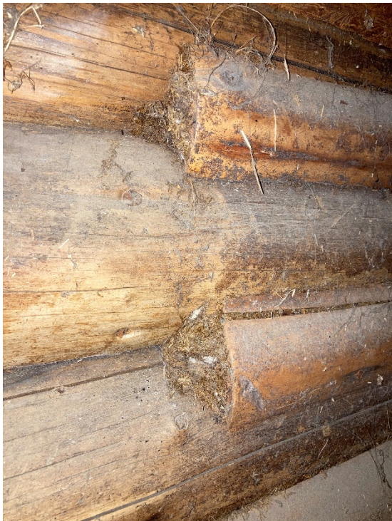
Figur 3-2 Eksempel på tetting i laftevegg fra Setton Gård
