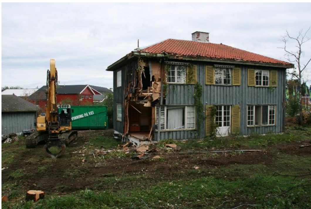
Vinning på vei. Riving av et hus på Jessheim i Ullensaker. Foto: Ola H. Fjeldheim
