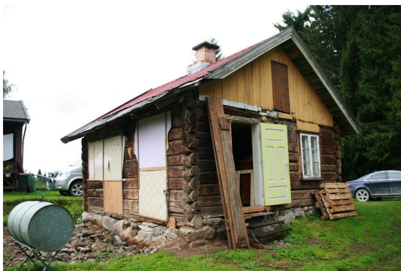
Husmannsstue i Løten i Hedmark. Når panelet ble tatt av viste det seg at huset er fra middelalderen. Foto: Ola H. Fjeldheim
