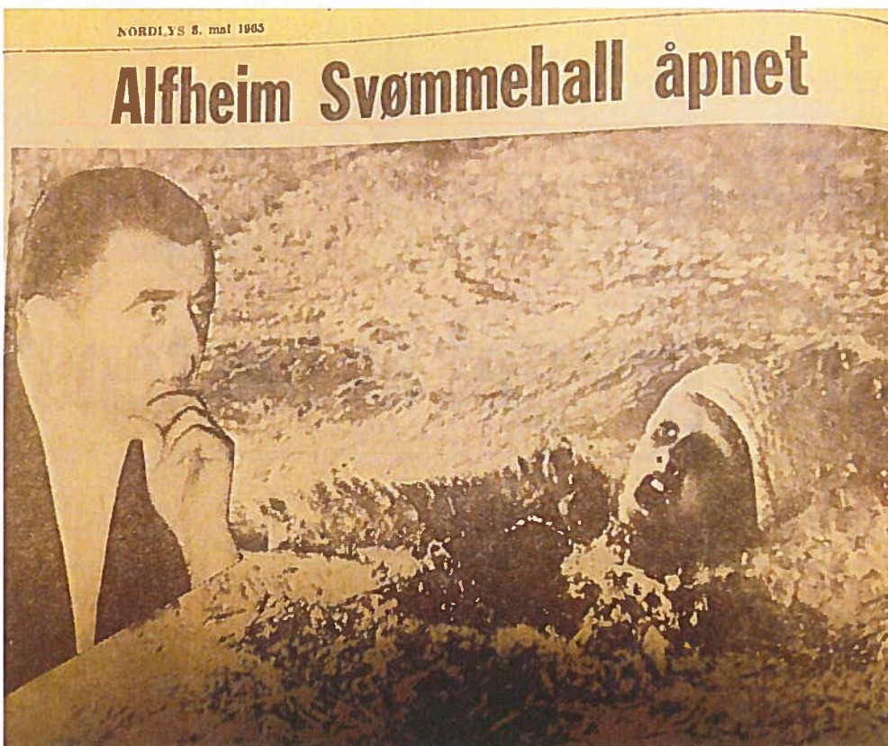
Prosjektets første byggetrinn er fullført i 1965, samme året som Ishavskatedralen.
