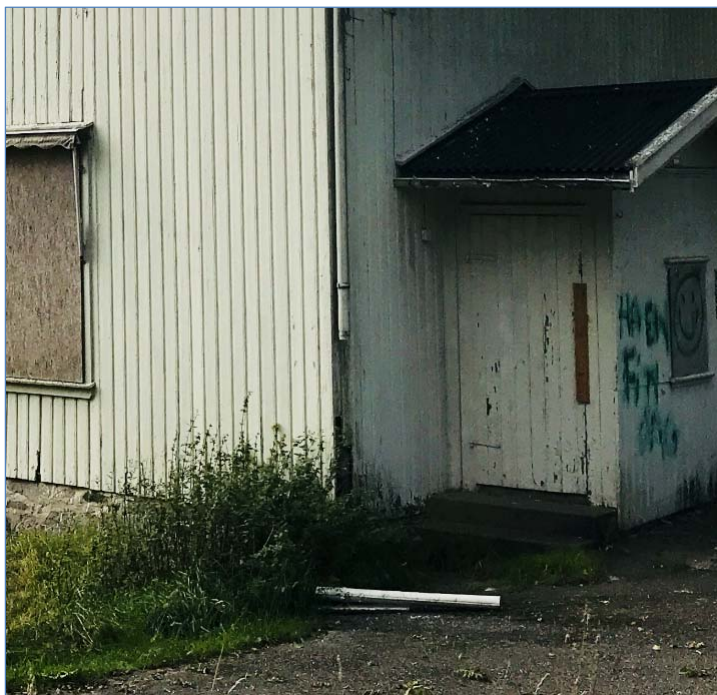
8 Ødelagt nedløpsrør
