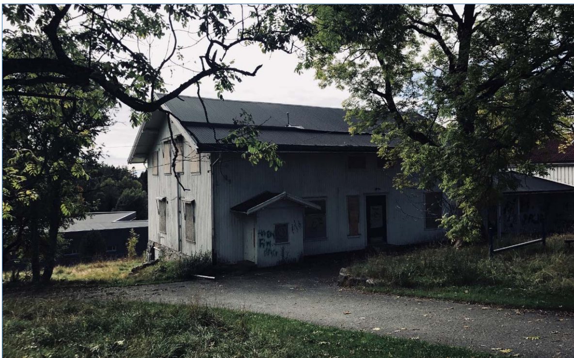
5 Den tidligere skolebygningen sett fra skolegården, sept. 2017
