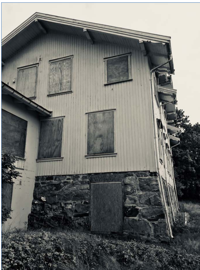
6 Gavlvegg i vest med detaljer typiske for sveitserstilen
