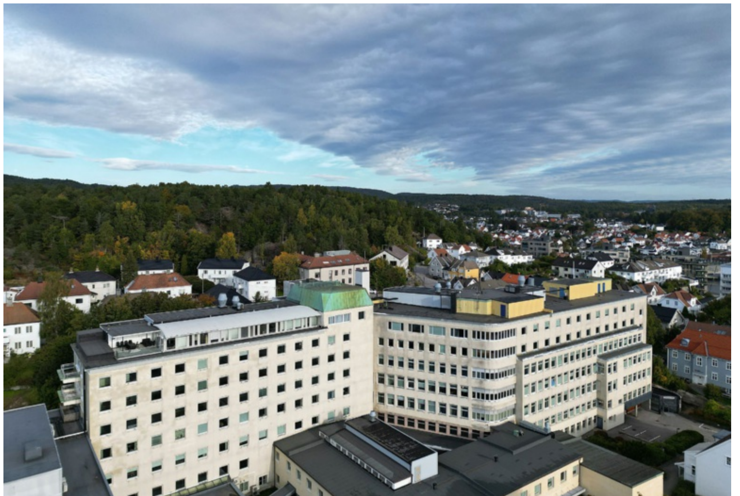
Sykehuset var et av Kristiansands første moderne byggverk. Den funksjonalistiske utformingen gjorde bygningen til et foregangsprosjekt, som vitnet om tidens ambisjoner innen medisin, økonomi, teknologi og arkitektur, skriver kronikkforfatterne. FOTO: KJARTAN BJELLAND
